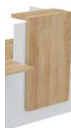
Parement installé sans entretoise
